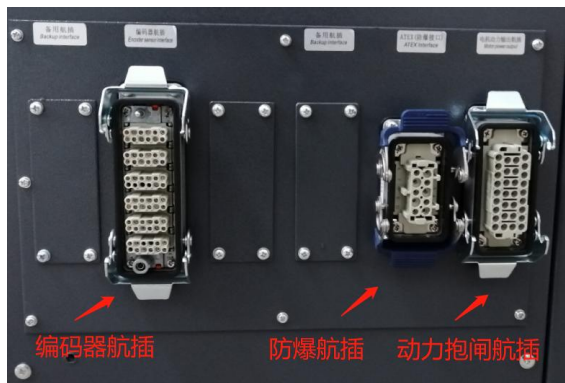
图 2-13 电控柜各航插定义
