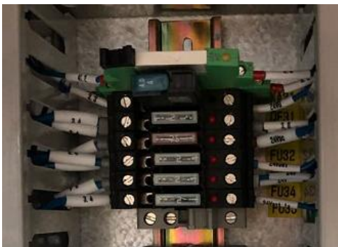
图 4-13 更换熔断器
