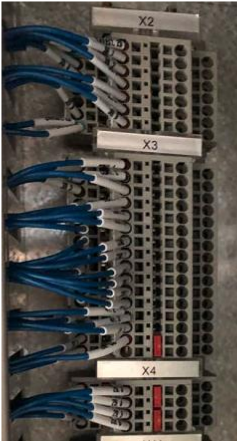
图 2-27 输入信号连接
