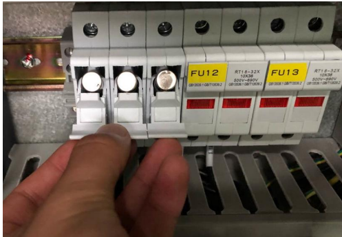
图 4-14 更换熔断器
