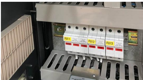
图 4-12 更换熔断器
