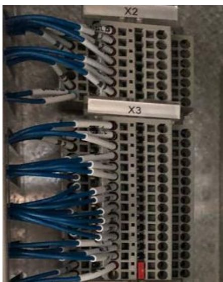
图 2-29 输出信号连接
