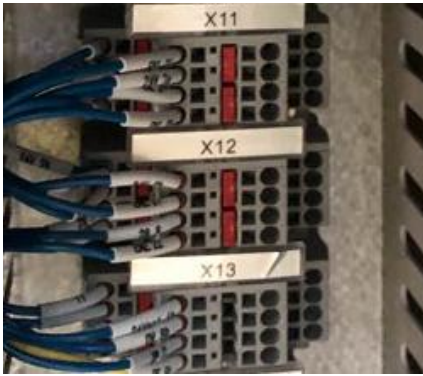
图 2-14 安全门连接端子
